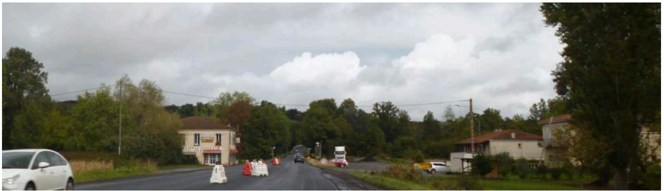
Photo 4 : Route nationale n°21 sens Mirande Auch – Travaux en cours ; UrbaDoc 2017
