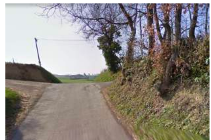
Vicnau : accès à la chapelle à droite rendu difficile en raison du talus et du faible gabarit de la voirie
